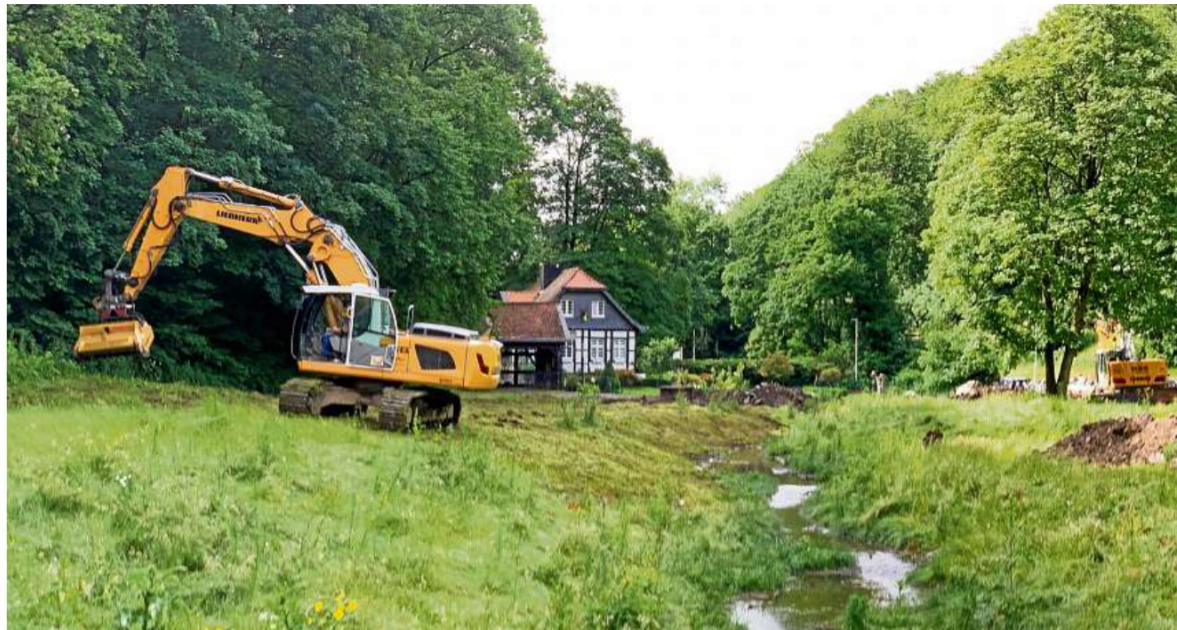
Nachdem die Renaturierung des Baarbachs abgeschlossen war, laufen die Arbeiten nun erneut. Zumindest das Haus von Erika Küchenberg ist nun trocken und ohne weitere Schäden.
